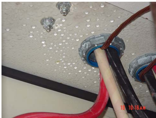
Figura 7 – Condiciones que causan un inaceptable PIP
